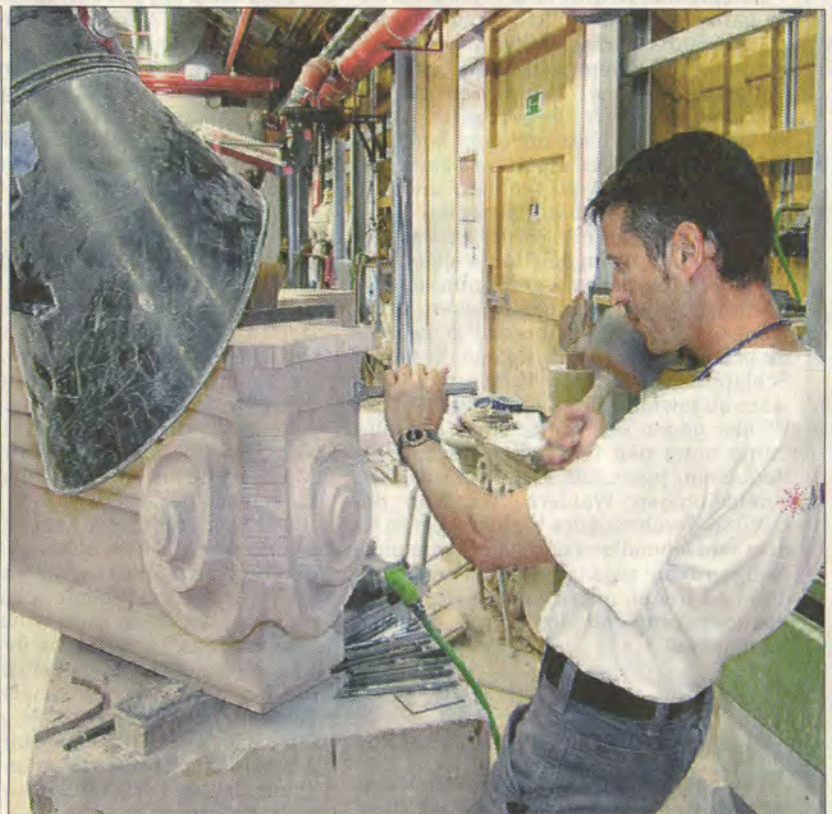
Hoch über den Dächern von Eberbach begutachtet Bauleiter Heinz Lang den Fortgang der Sanierungsarbeiten an den Türmen der katholischen Pfarrkirche St. Johannes Nepomuk (l.). Rechts: Steinmetzmeister Thilo Schlick bei der Arbeit. Mit Bildhauerwerkzeugen wird die Oberfläche eines Sandsteinkapitells für die Türme scharriert. Fotos: Nolten-Casado
