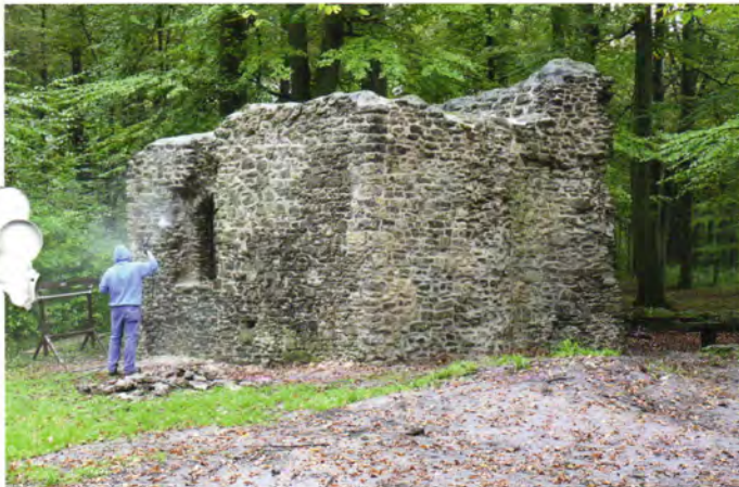
Abb. 1: Uwe Mehlmann von der Firma Walz beim „Kärchern“ der Sakristeimauern vor der Neuverfugung Foto: G. Schwitalla, hA
